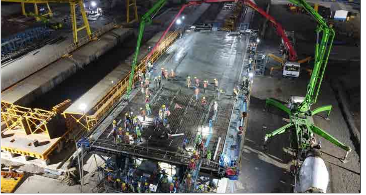
आनंद, गुजरात येथे फुल स्पॅन गर्डर टाकण्याचे काम प्रगतीपथावर आहे
