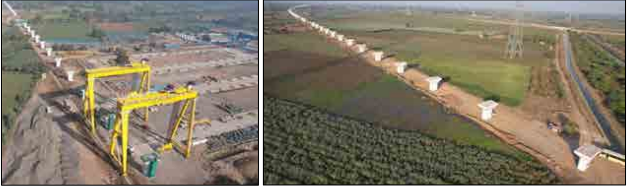
गुजरात मधील पिअर आणि पिअर कॅम्पची कामे पूर्ण करणे
