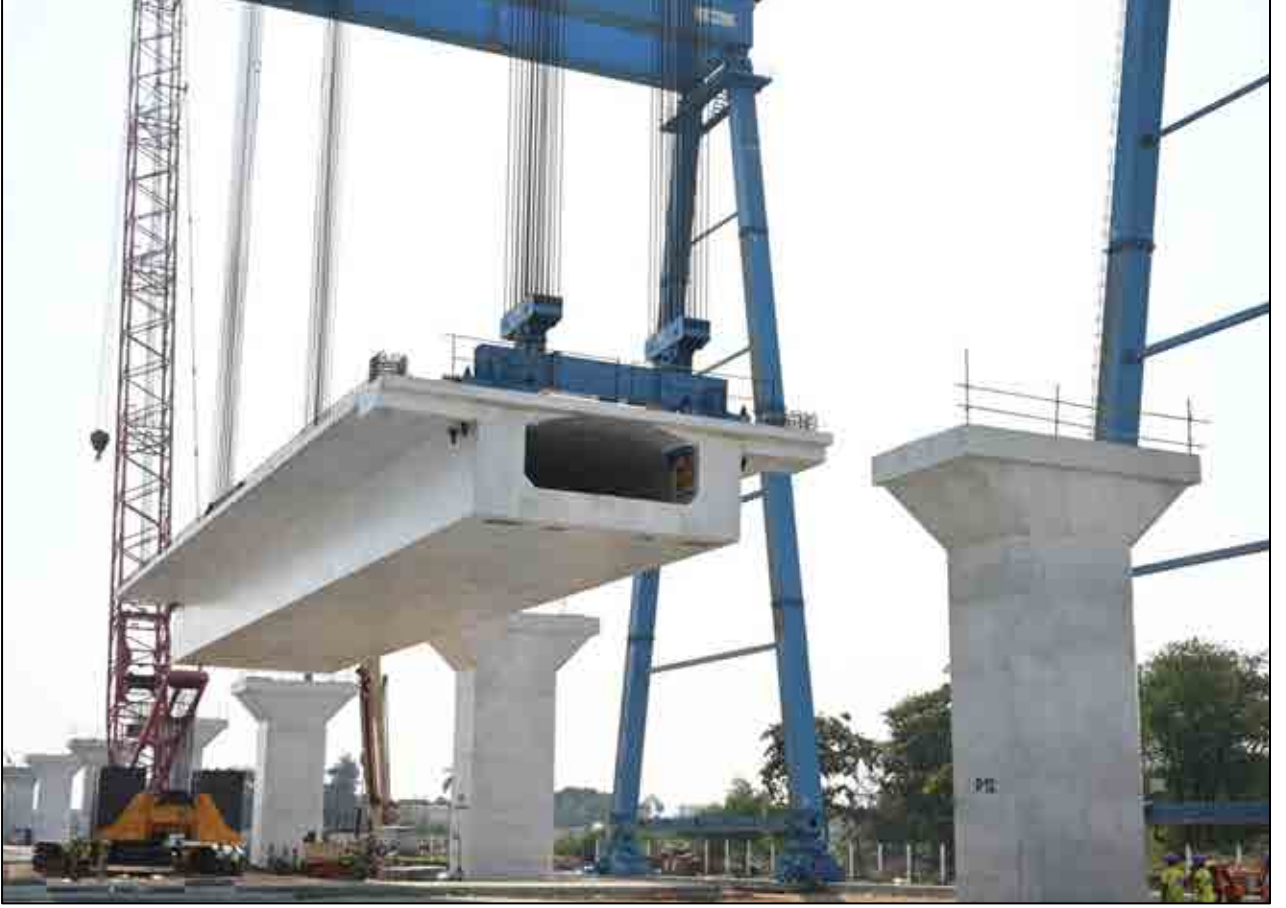
गुजरात मधील 40 मीटर लांबीच्या फुल स्पॅन गर्डरचे लाँचिंग
