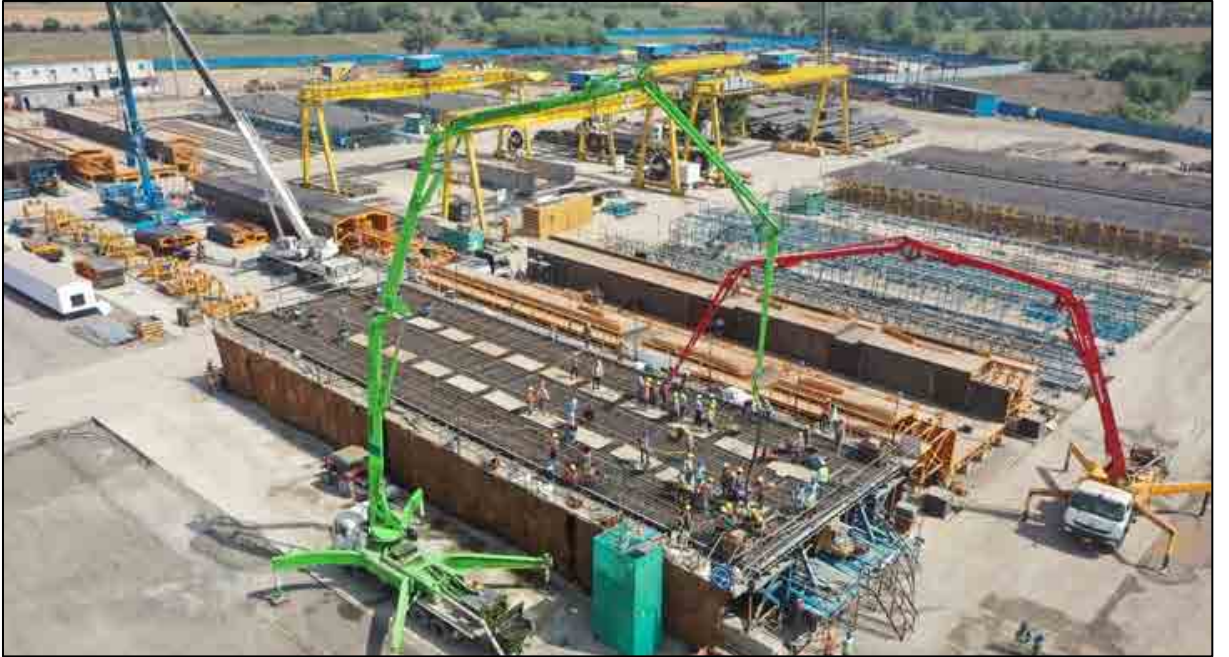
आनंद, गुजरात येथे फुल स्पॅन सेगमेंट कास्टिंग प्रगतीपथावर आहे
