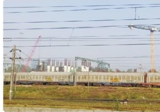
अहमदाबाद के साबरमती इलाके में बुलेट ट्रेन का निर्माणाधीन स्टेशन।
