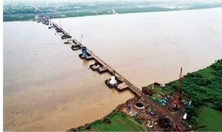
नर्मदा नदीवर प्रगतिपथावर असलेले पुलाचे काम.
