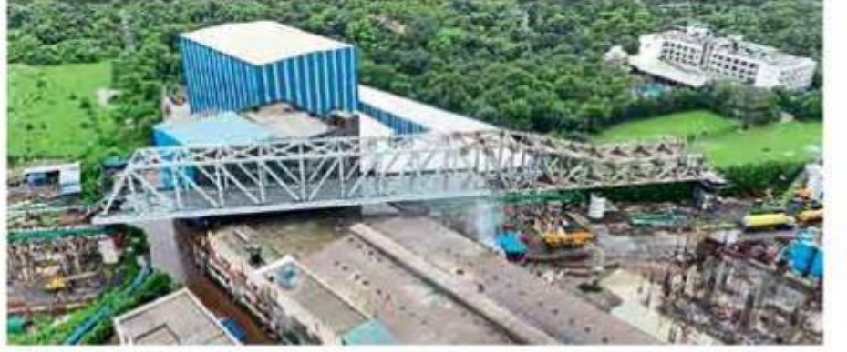
मनोर : बुलेट ट्रेन प्रकल्पासाठी सिल्वासाजवळ उभारण्यात आलेला पोलादी पूल.
