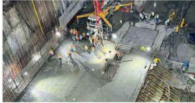
ठाणे : बुलेट ट्रेन स्थानकाचा पहिला बेस स्लॅब जमिनीपासून ३२ मीटर खोलीवर यशस्वीरीत्या टाकण्यात आला आहे.
