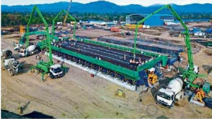
मुंबई : बुलेट ट्रेन प्रकल्पात पालघरमधील डहाणू येथे पहिला ४० मीटर लांबीचा (पीएससी) बॉक्स गर्डर उभारण्यात आला.
