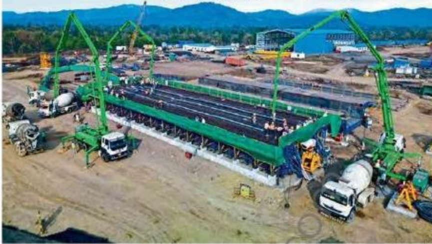
मुंबई : बुलेट ट्रेन प्रकल्पात पालघरमधील डहाणू येथे पहिला ४० मीटर लांबीचा (पीएससी) बॉक्स गर्डर उभारण्यात आला.
